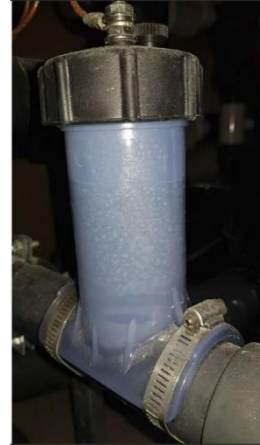
FIGURA 5- Ânodo de sacrifício e instalação no circuito da água da piscina.
