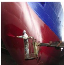
Tintas com cobre para evitar incrustação
